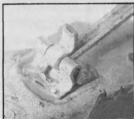
Литые части шарнира на шпанге с проветрым стержнем, на котором вращается специально изогнутая рифленая игла.
