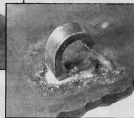
Ловящий крюк из плоской полосы на знаках Кригсмарине, припаянный с помощью монтажной пластины.
